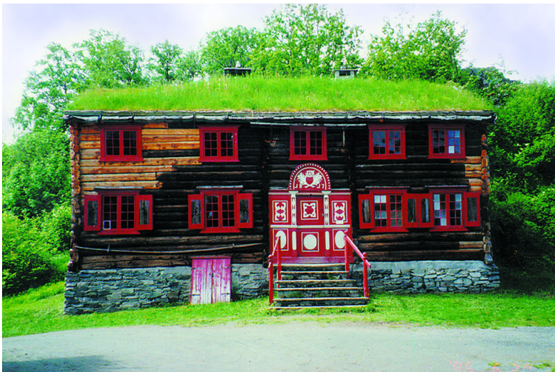
Zöldesített magastető (norvég példa). A kő lábázati falra épült több száz éves boronafalás szerkezet hőszigetelését a résekbe tömött gyapjúszálakkal fokozták, a tető természetes hőszigetelését, és a nyári túlmelegedés elleni védelmet pedig a fűtető biztosítja.
